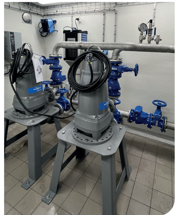
Torrt uppställda boosterpumpar i Granås som ökar tryck och flöde i tryckledningen.
