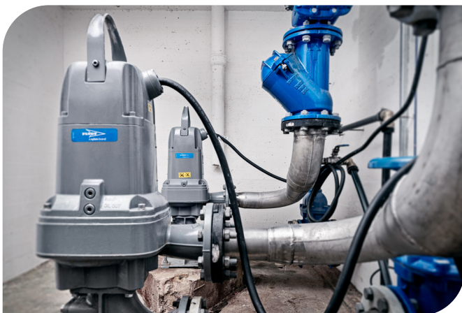
Flygt Concertor 6020 Pumpen mit Adaptive-N-Hydraulik in einer kommunalen Abwasserpumpstation
