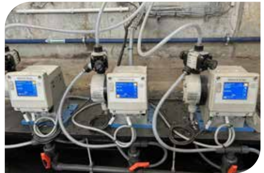
Neue Membrandosierpumpen
