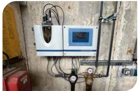
Eines von zwei DEPOLOX Pool Compact-Geräten
