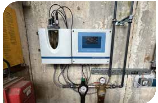
L'un des deux systèmes DEPOLOX Pool Compact
