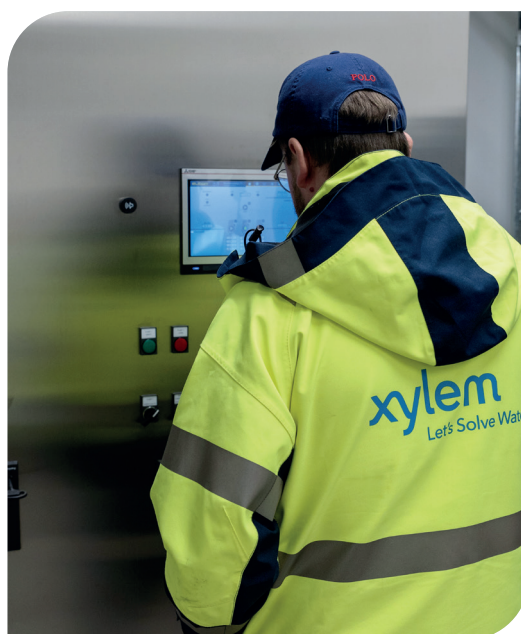
Pumpstyrningen innehåller en pekskärm för enkel kontroll.
