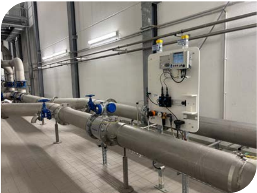
Abb. 3 und 4: Die WTW-Trinkwassertafel überwacht kontinuierlich und zuverlässig die Wasserqualität im Wasserwerk Osthofen (oben vor der Riesleranlage, unten im Ablauf der SEC-Anlage)
