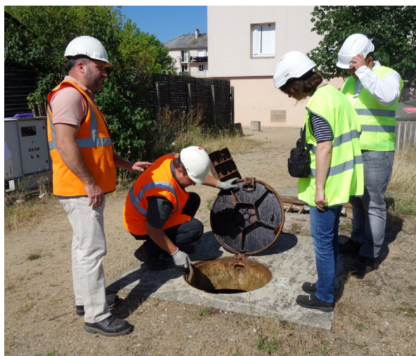
Préparation de l'installation de la pompe Flygt 3069
